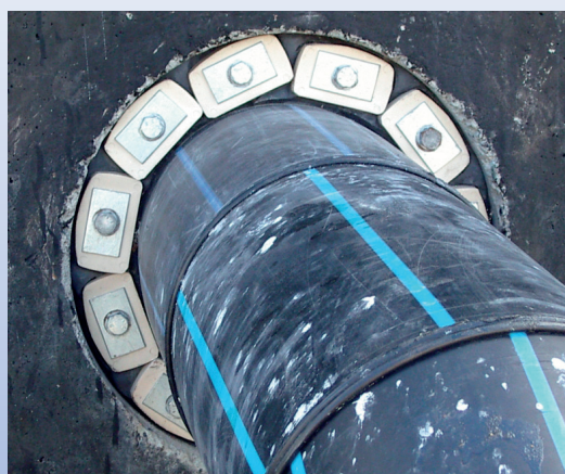
Водопроводные трубы диаметром 315 мм
